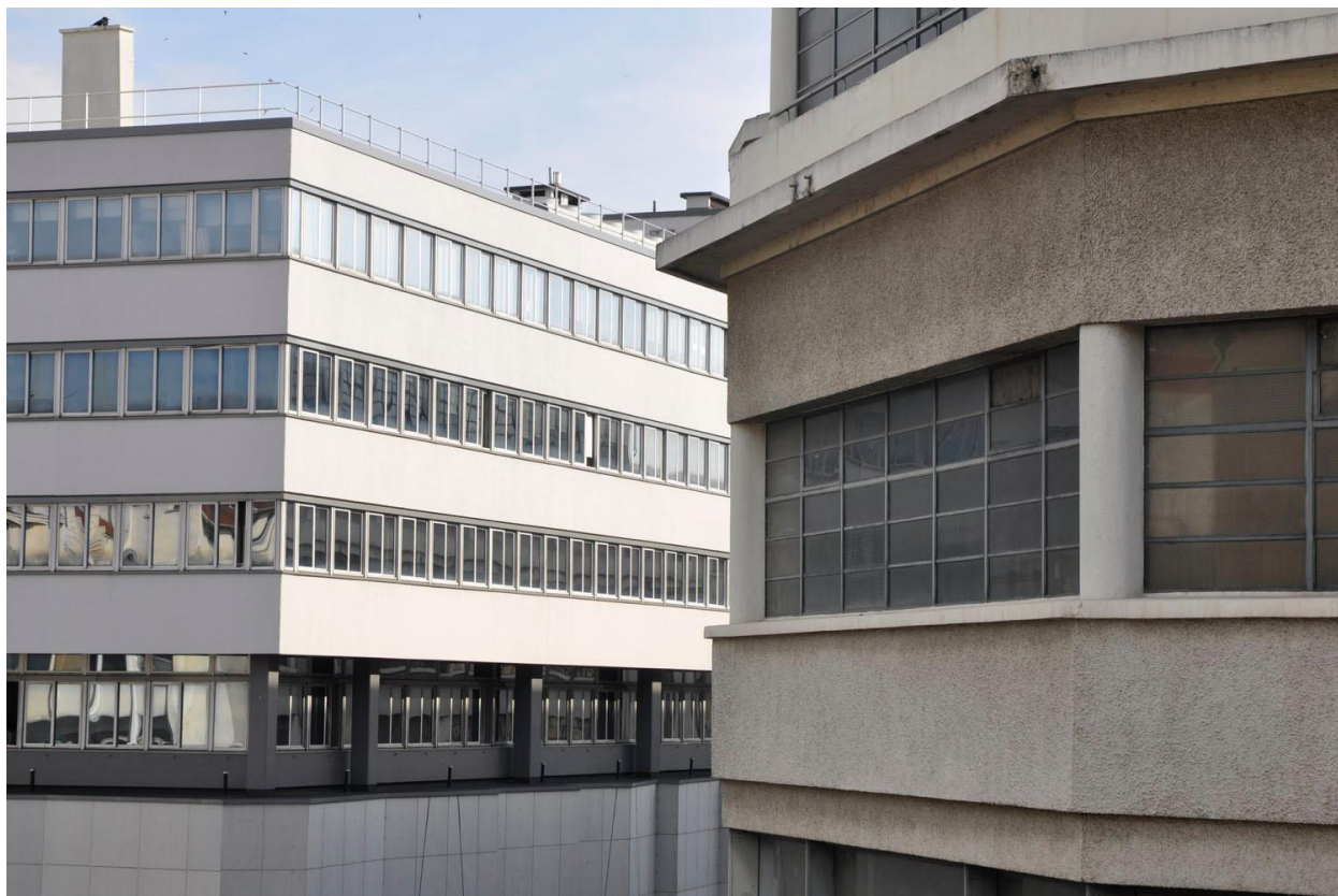
Détail façade mur rideau
