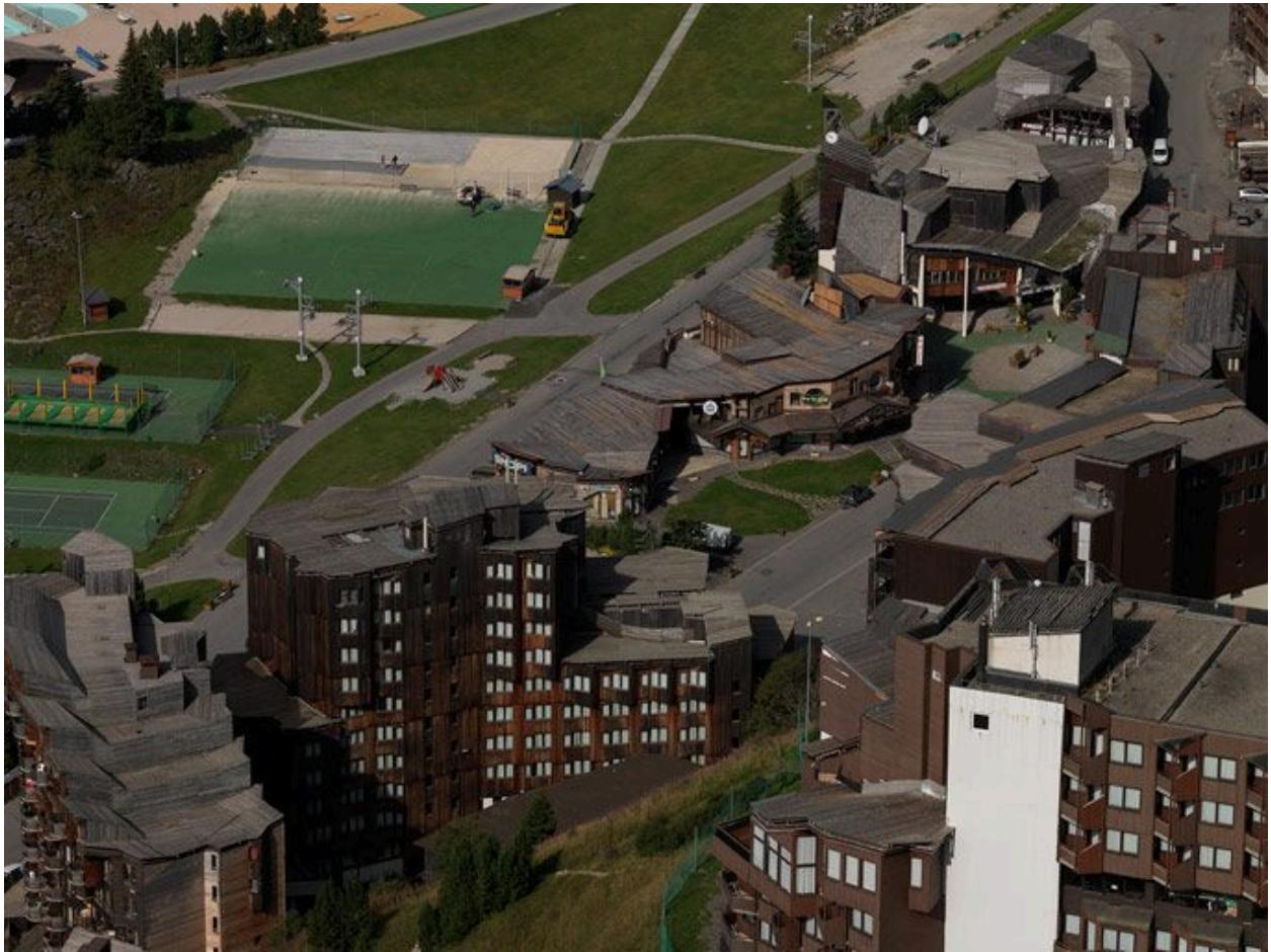
Vue d'ensemble des toitures depuis le sud-est
