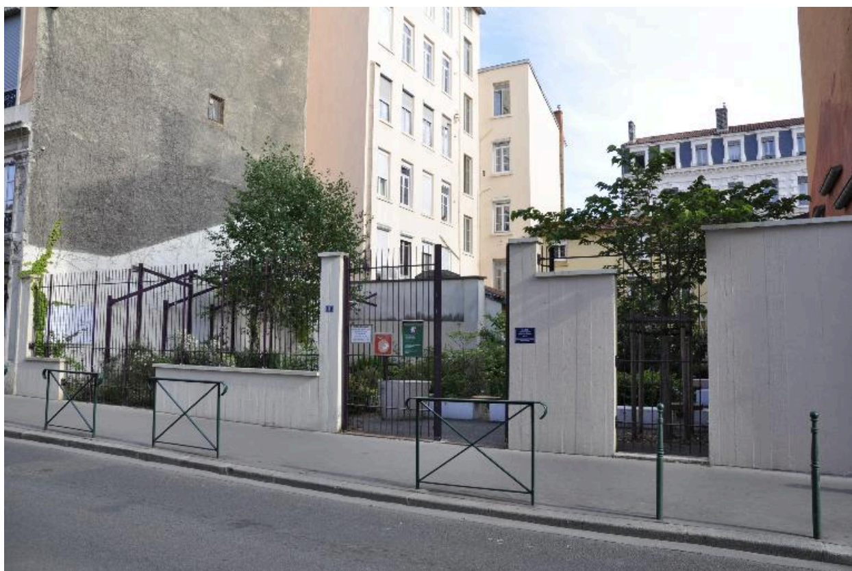
Vue d'ensemble sud est depuis la rue du Chariot d'Or
