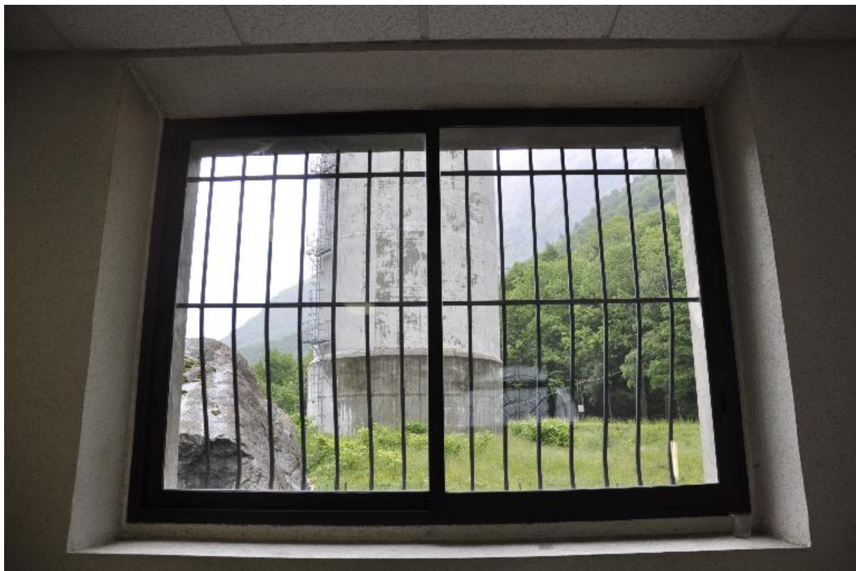
Détail d'une baie des bureaux donnant sur la cheminée d'équilibre
