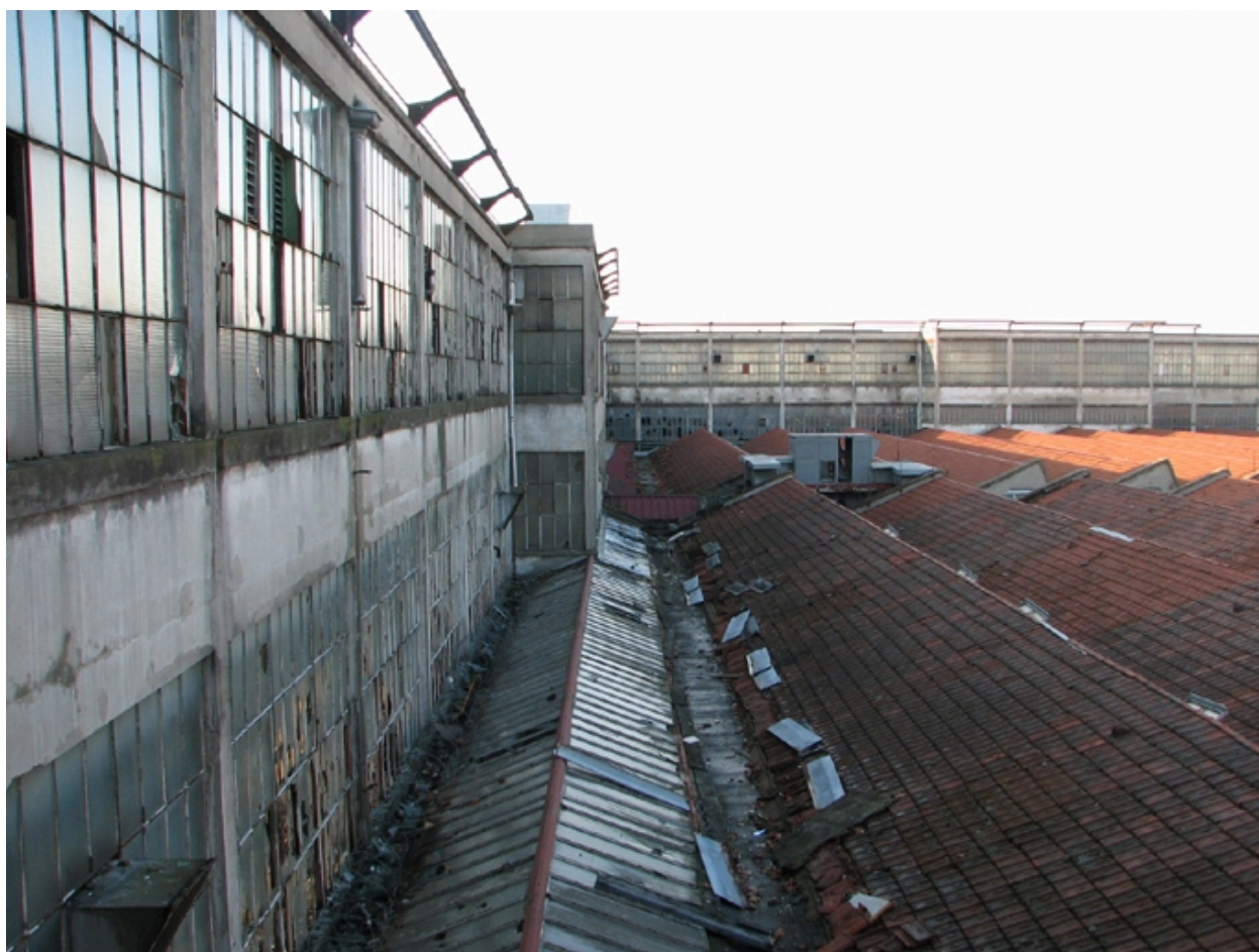
Vue nord-ouest des toitures
