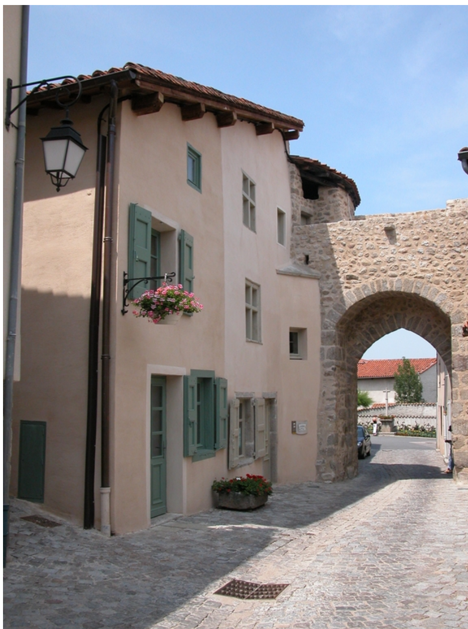
Vue générale depuis le sud (état en 2006).
