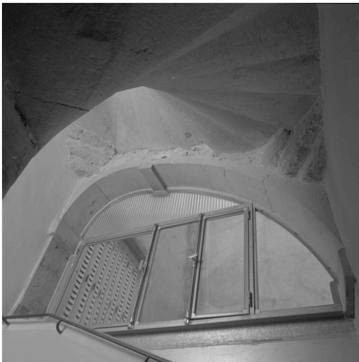
Escalier : arc rampant.
