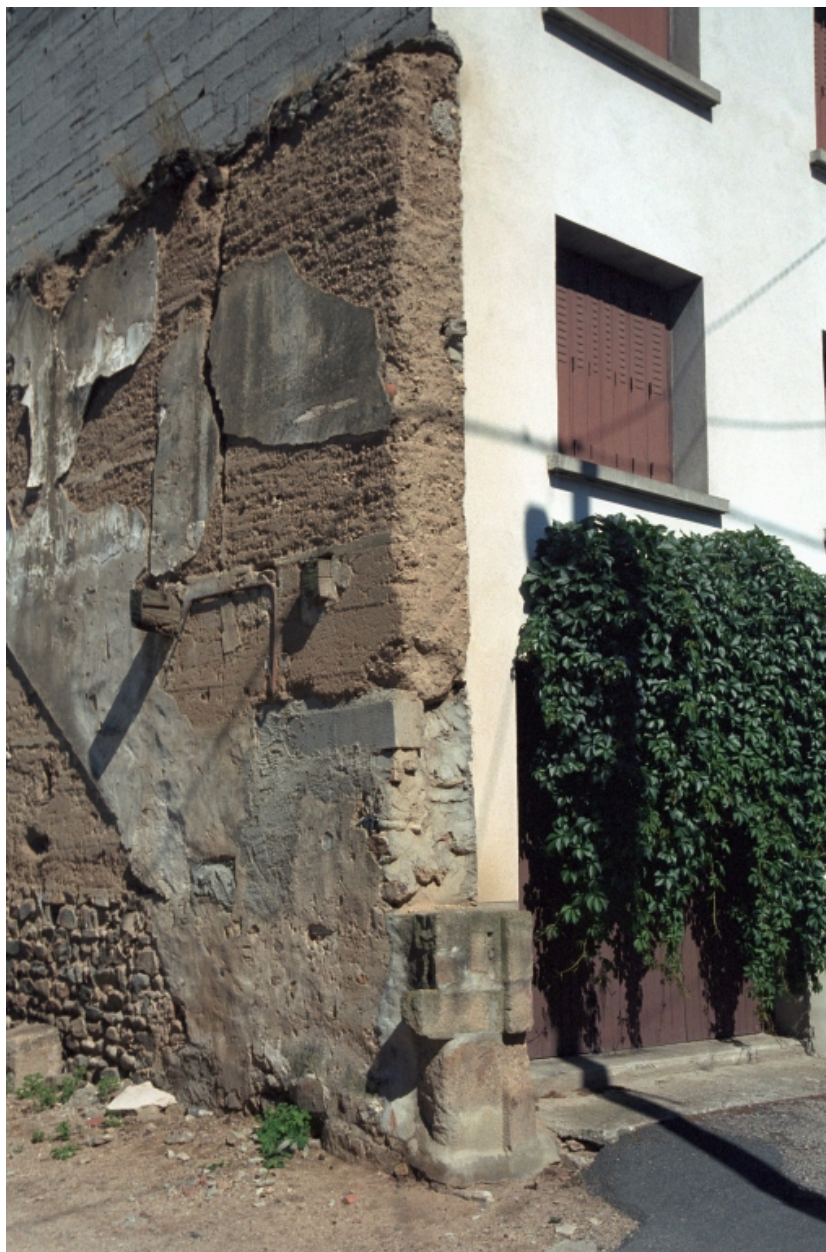
Boën, îlot 12, Ph. Raymond (rue) 37. Détail du mur pignon en pisé de la maison.
