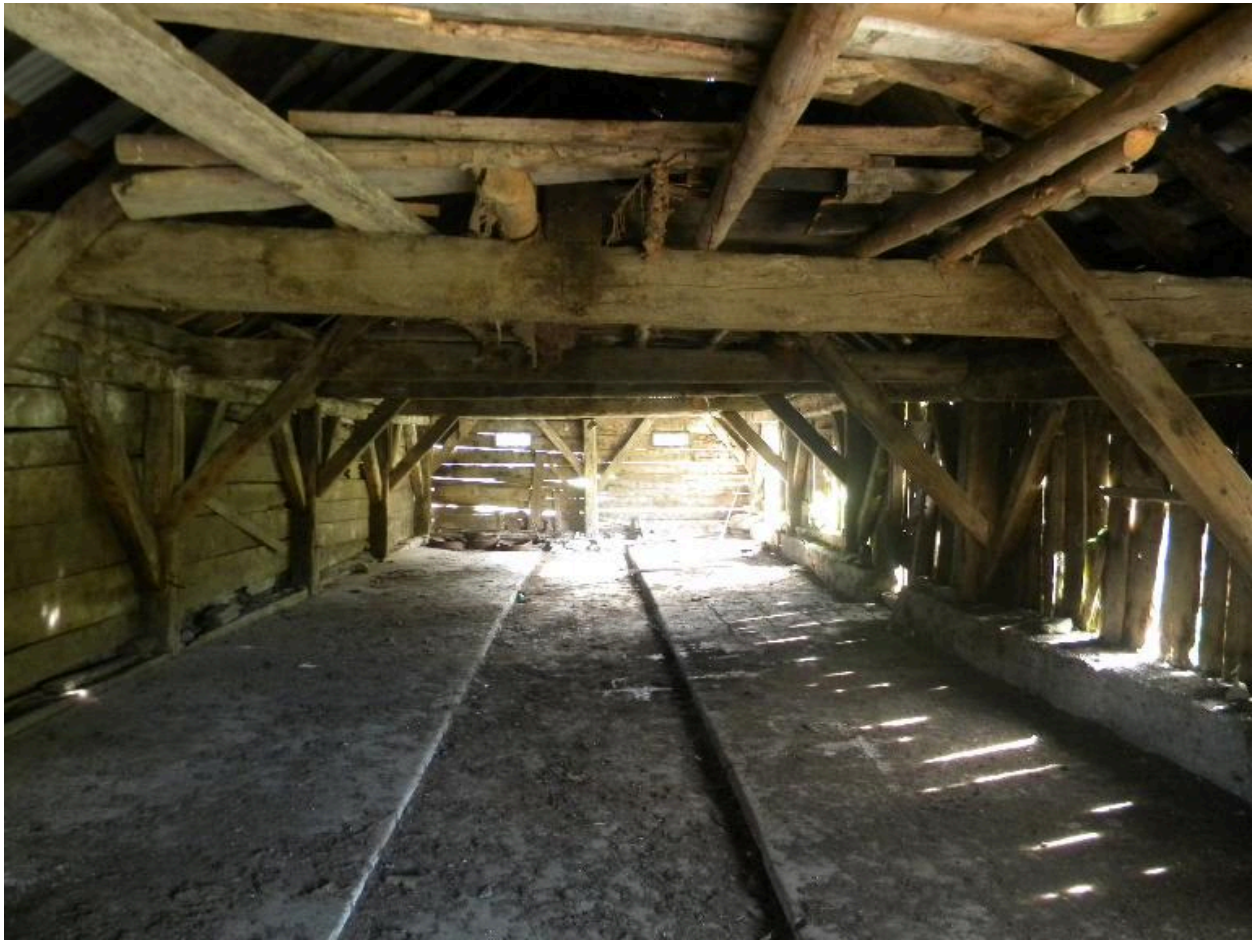
Etable : vue d'ensemble intérieure vers le sud.
