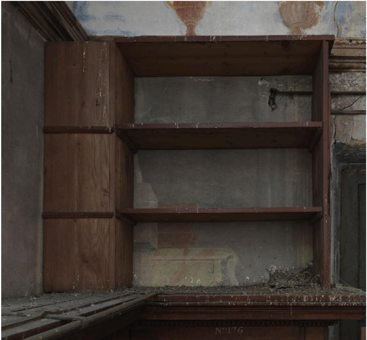
Mur sud, partie latérale gauche
