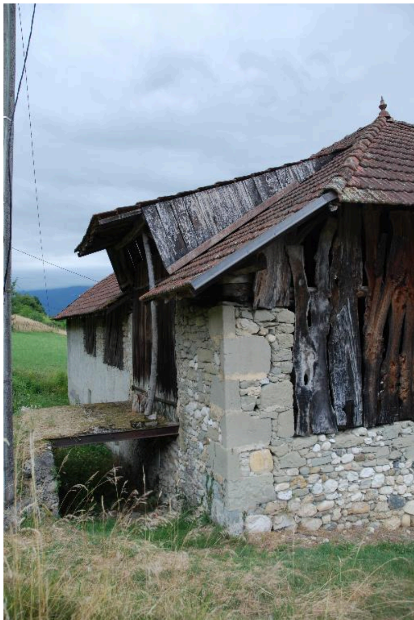
Vue arrière, baie fenière.
