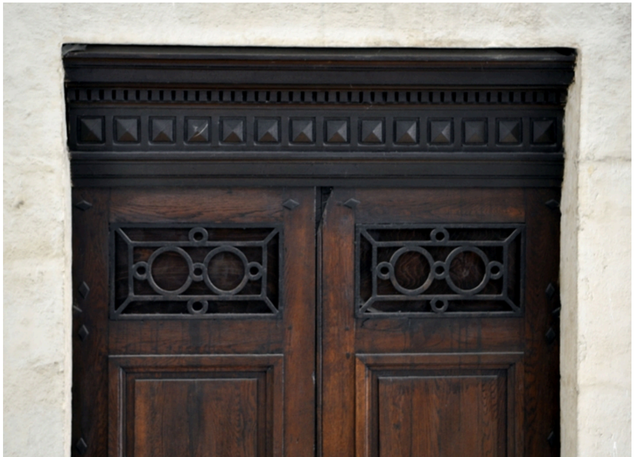
Bâtiment C. Escalier C : porte du réfectoire. Détail de l'imposte.
