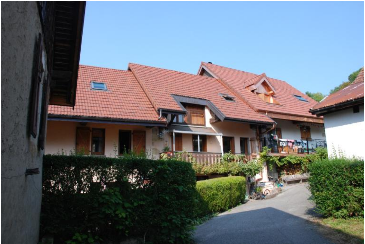
Viuz-Nord, C4 1980, 1819, ensemble de trois maisons mitoyennes. Vue d'ensemble des façades sud des maisons.
