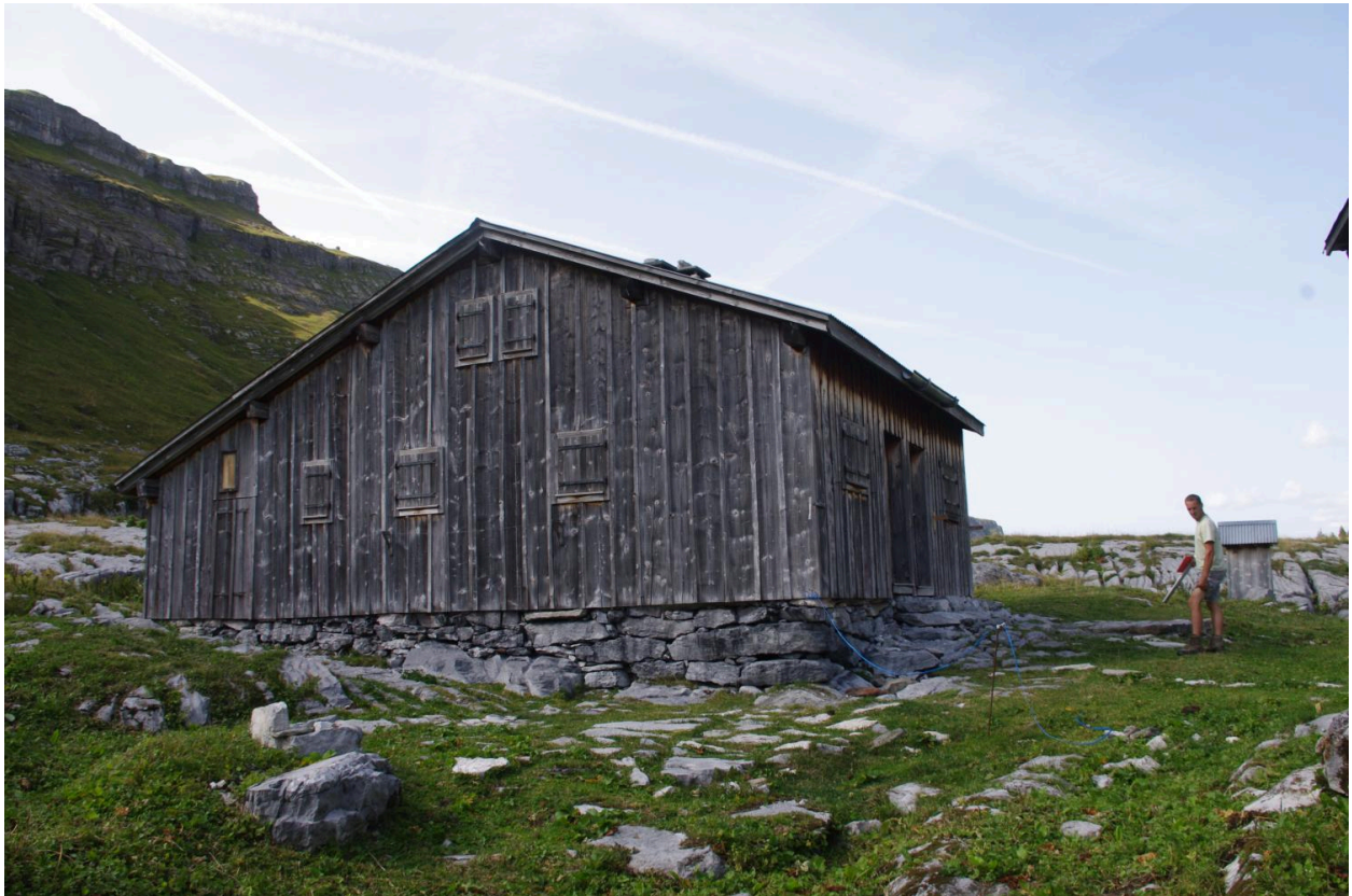
Vue de l'élévation sud-est
