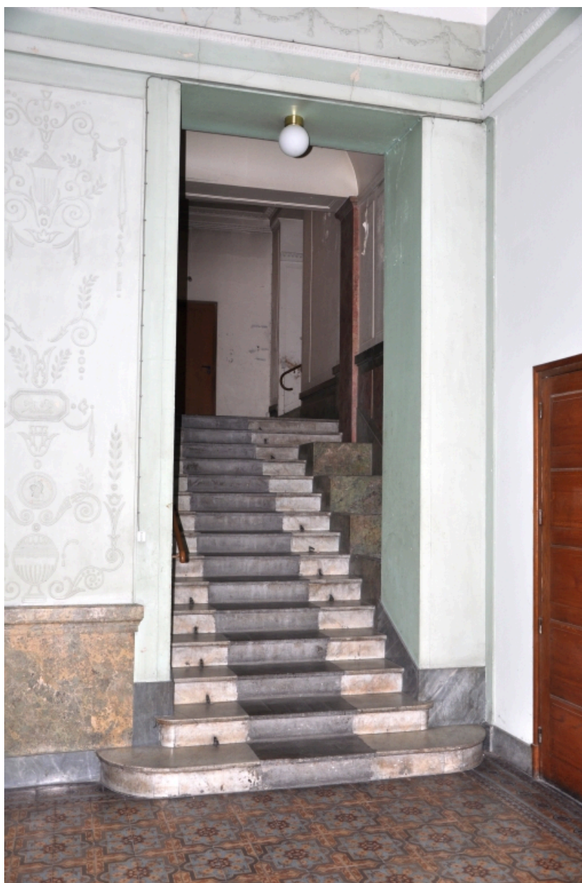
Corps principal : escalier d'accès à l'aile
