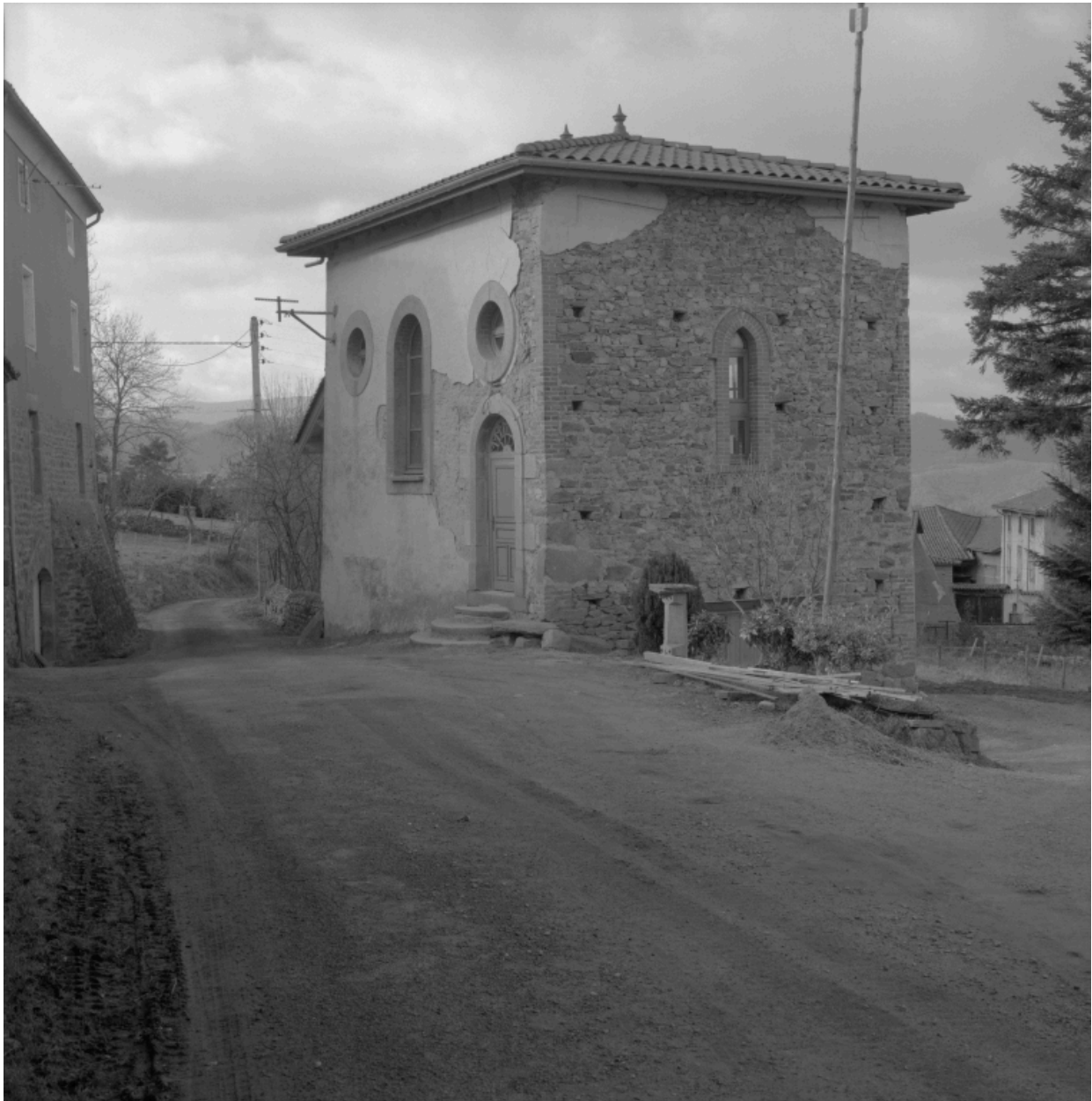
Vue d'ensemble de la chapelle depuis le sud-est (été 2002, après restauration).
