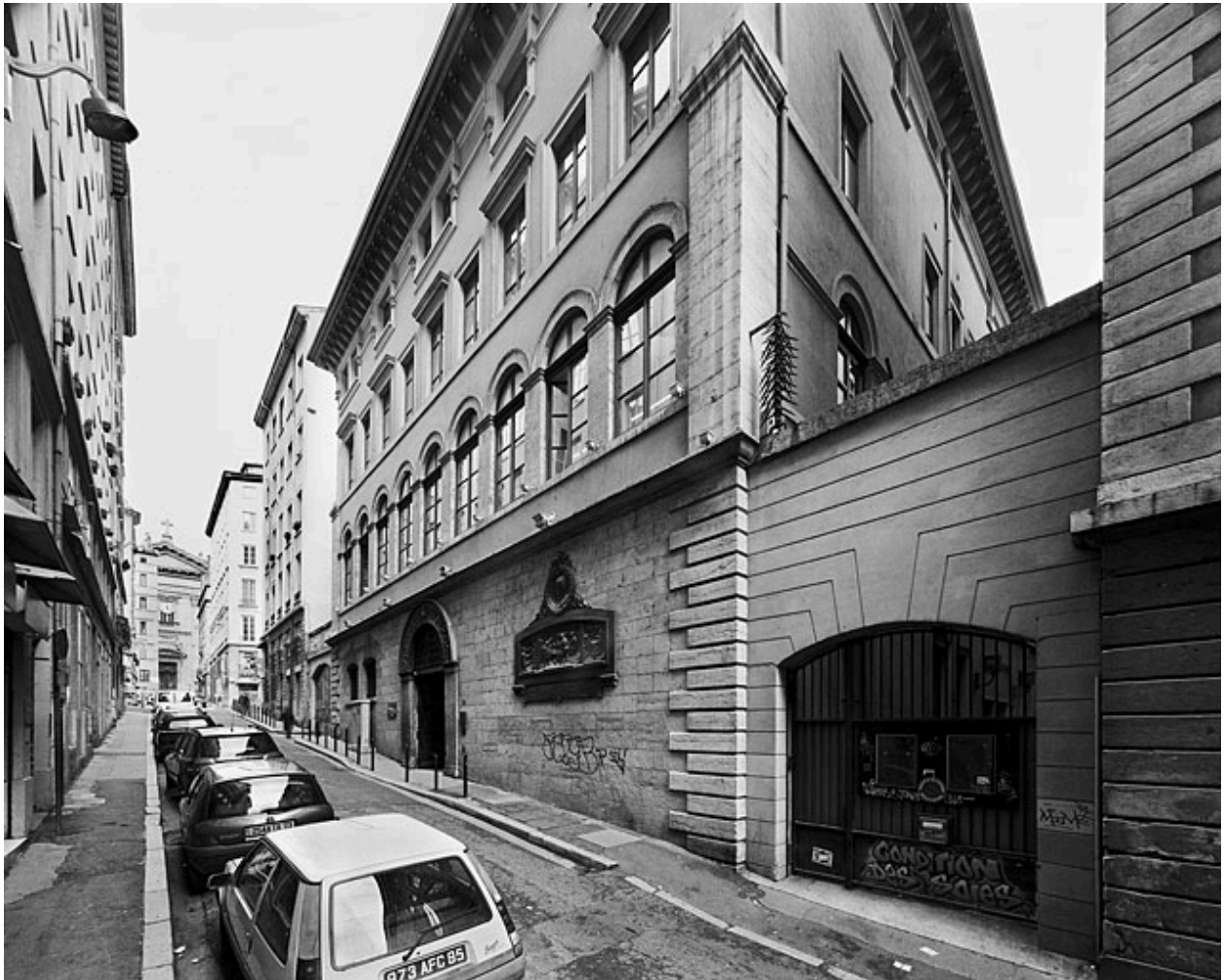
Vue sud-est du bâtiment
