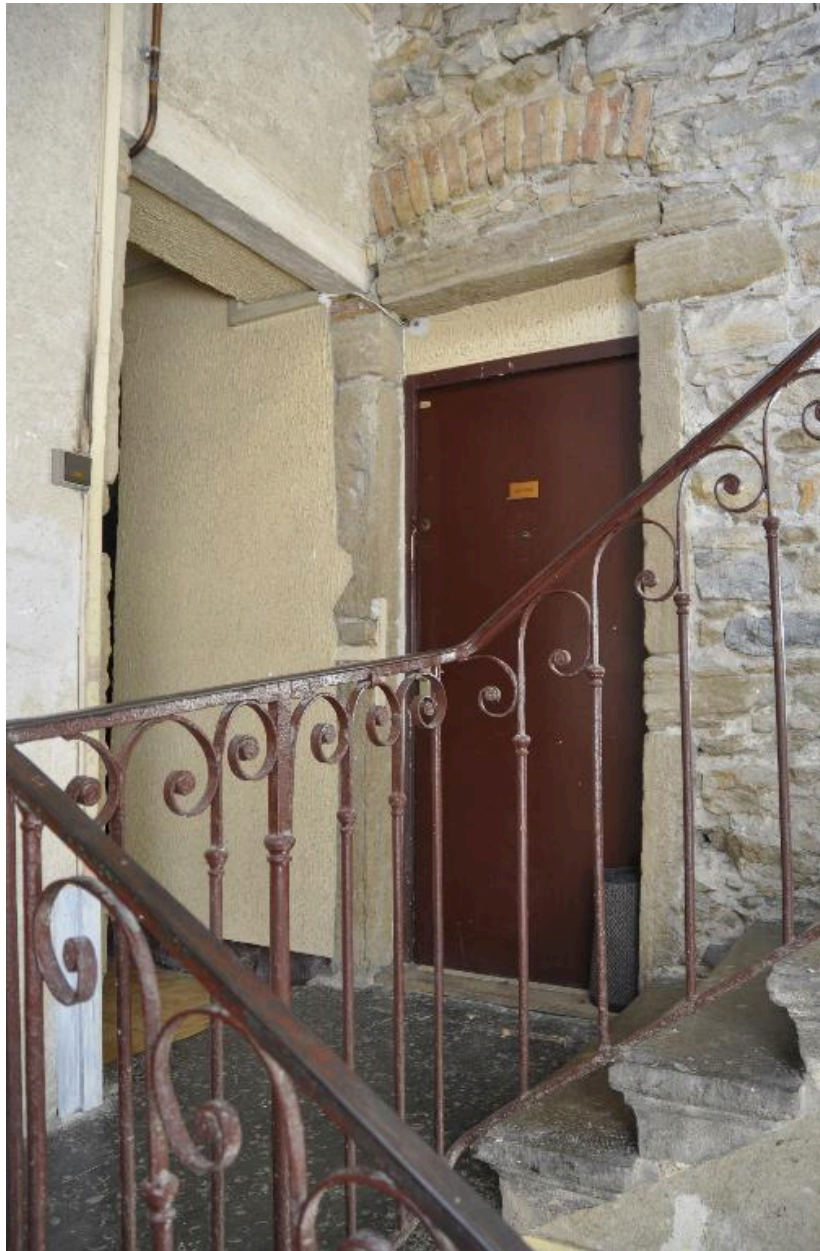
Vue intérieure : portes palières, encadrements en pierres
