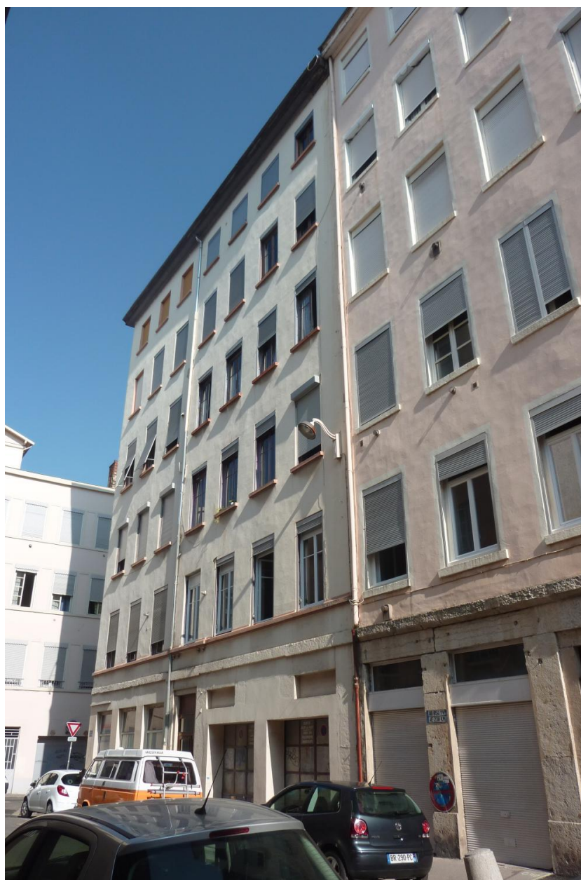
Vue d'ensemble de l'immeuble-atelier
