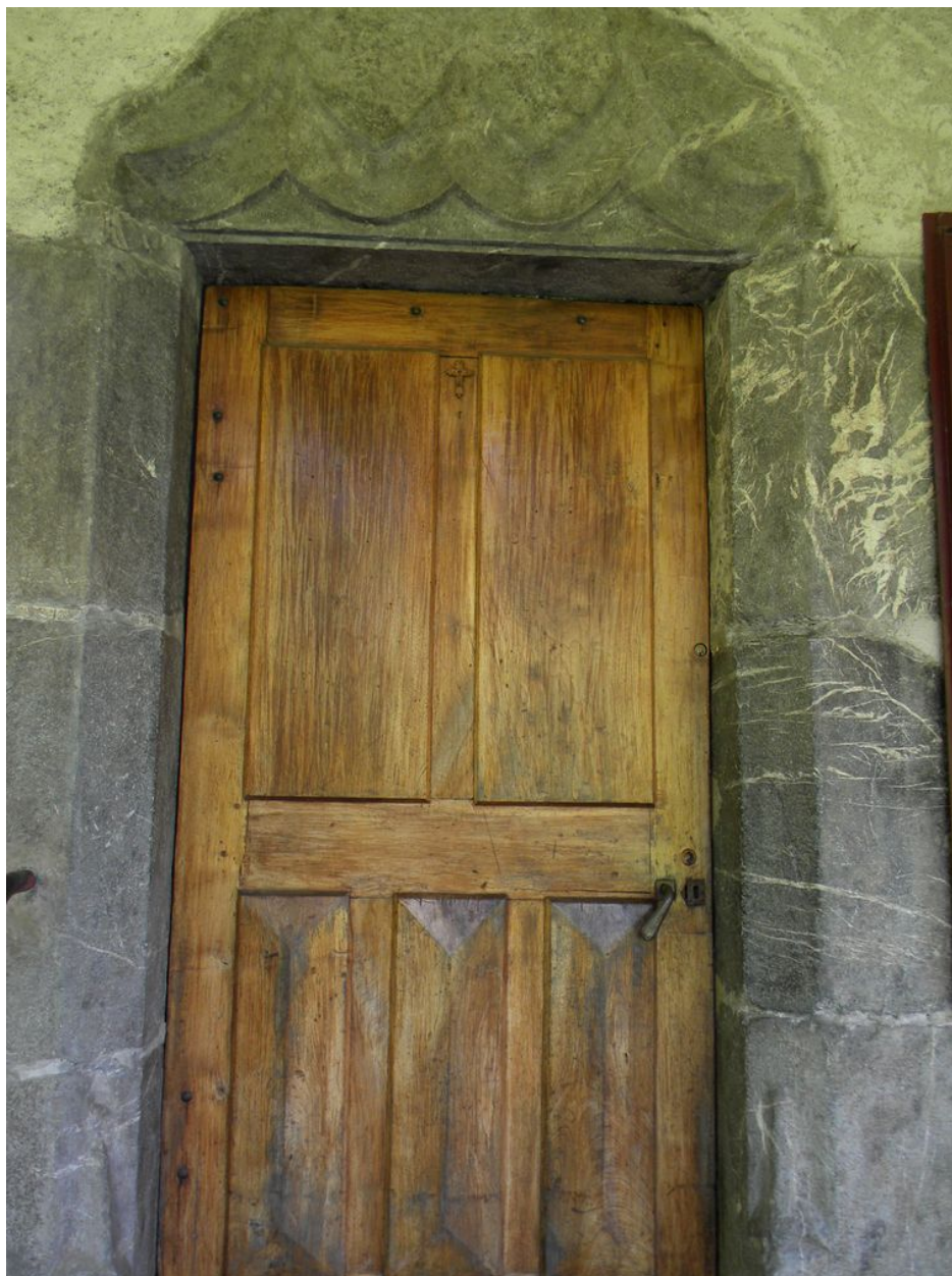
Vue de l'encadrement de porte surmonté d'un linteau à triple accolade.
