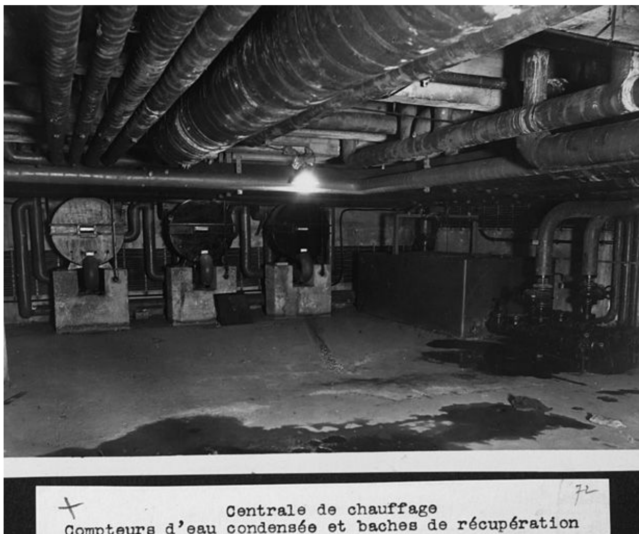
Centrale de chauffage. Compteurs d'eau condensée et baches de récupération. Photogr., vers 1960
