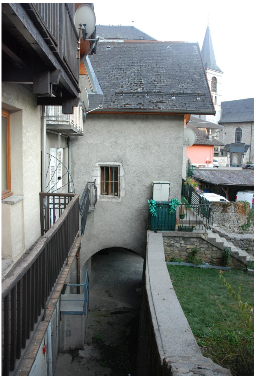
Passage commun le long du côté nord du square de Stetten (2018 E1 1204, 1209) ; au fond, construction en surplomb au-dessus du Gargot.
