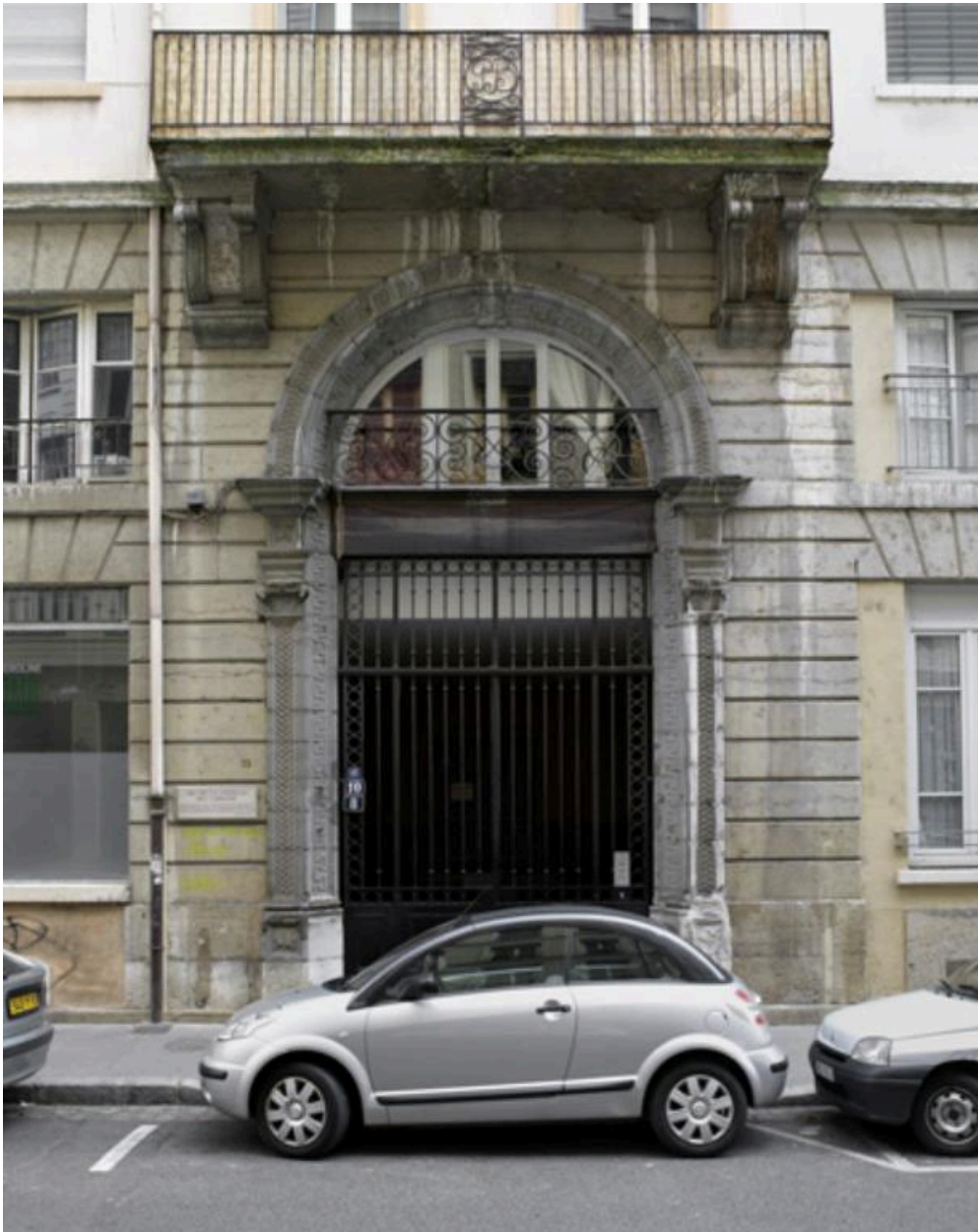
Portail : vue générale
