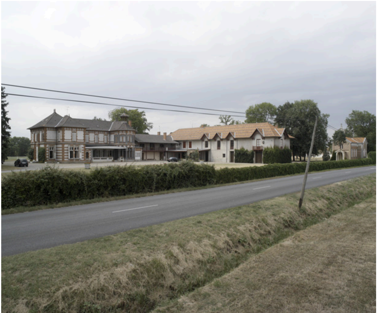
Vue générale depuis le sud-ouest.
