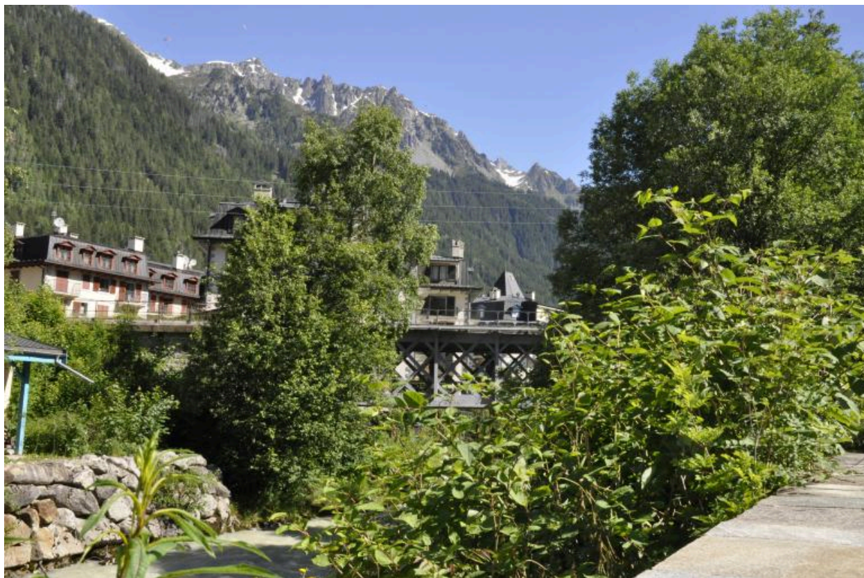
Vue du tablier métallique en face aval
