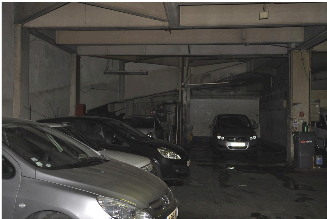
Vue intérieure du parking souterrain
