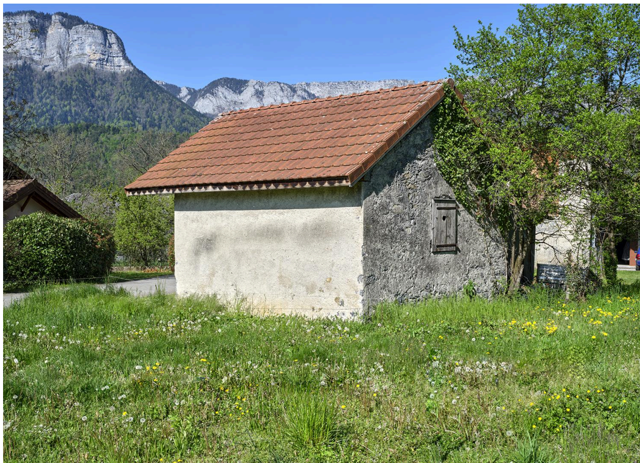
Vue depuis l'arrière.
