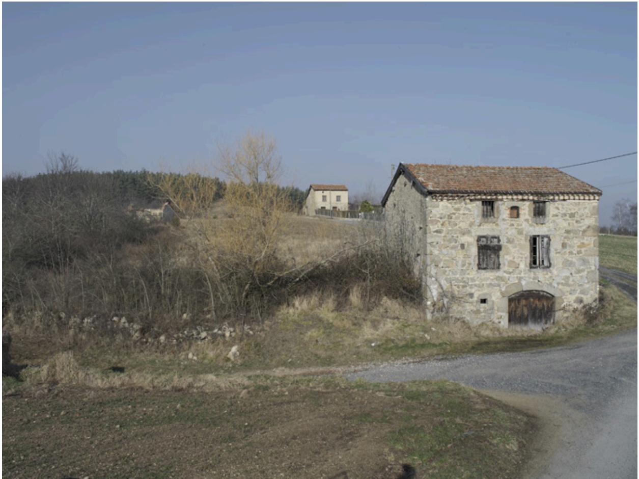
Vue d'ensemble de trois quarts avant gauche du cuvage.
