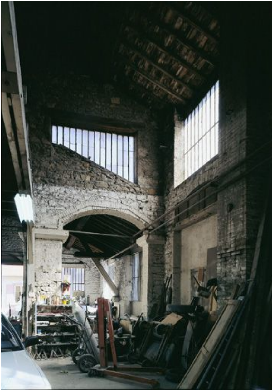
Vue des différentes baies, fenêtre rampante et lanterneau en bois
