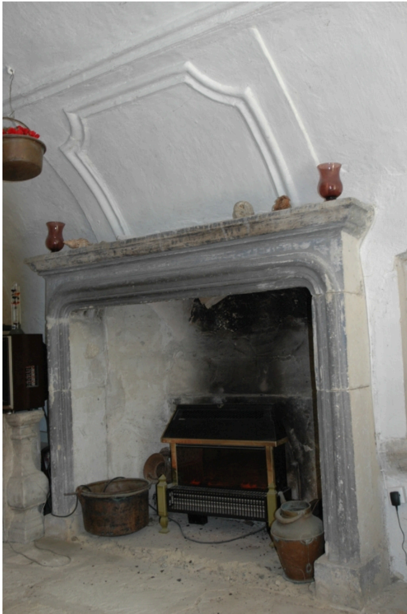
Vue de la cheminée du salon
