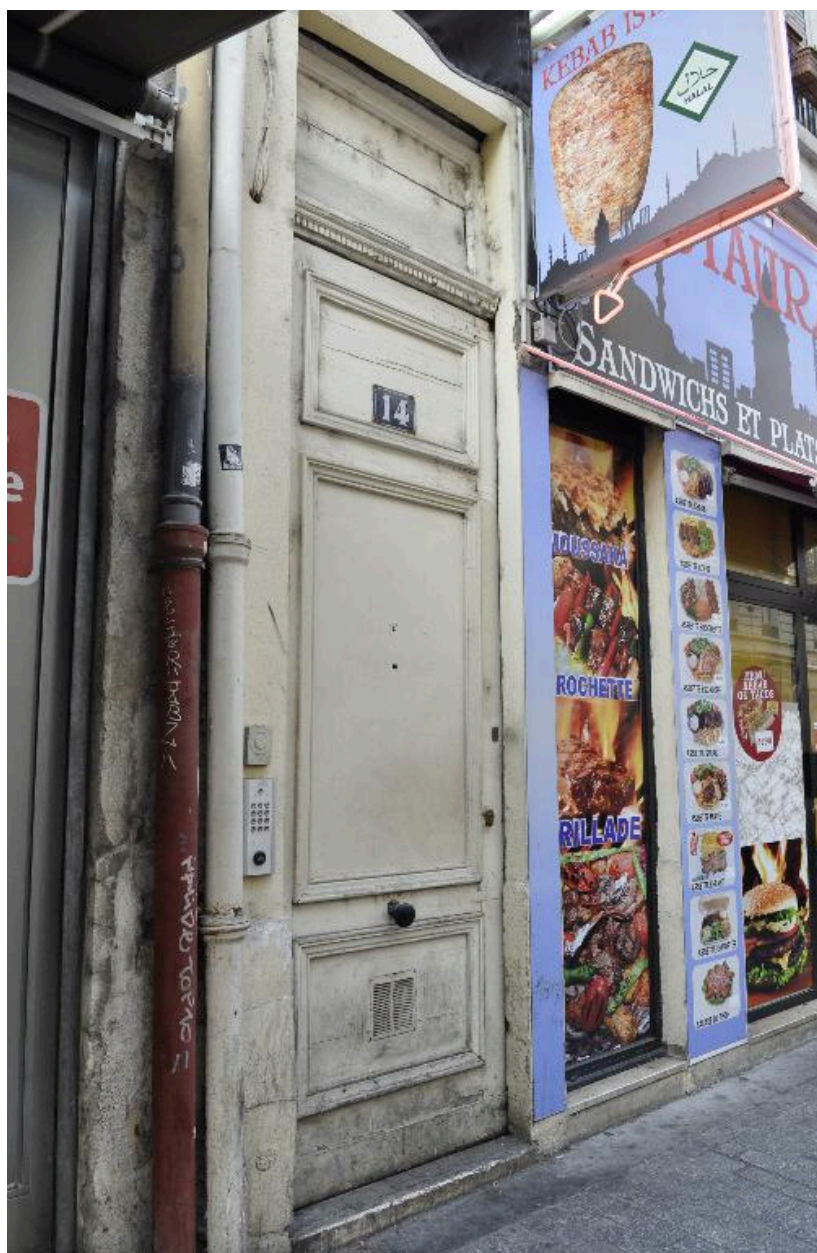
Vue rapprochée de la porte piétonne
