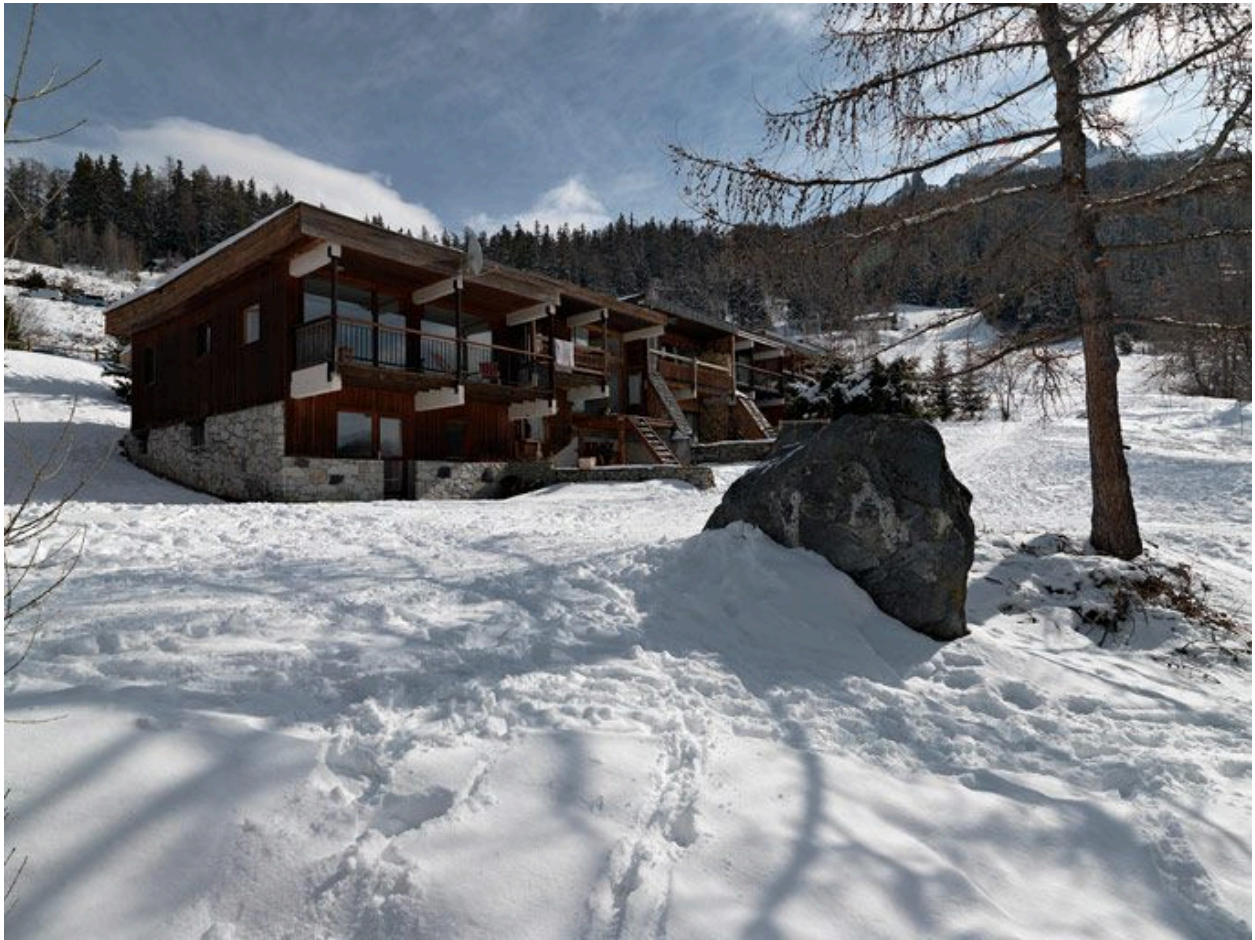
Chalets sur deux niveaux. Façade sud
