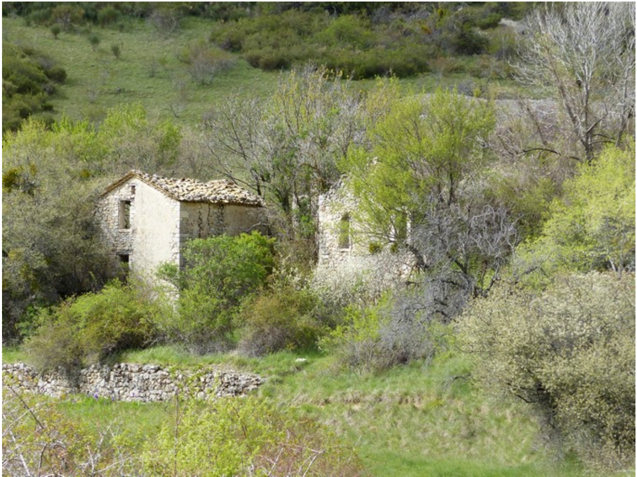
Vue de situation prise du sud-est.
