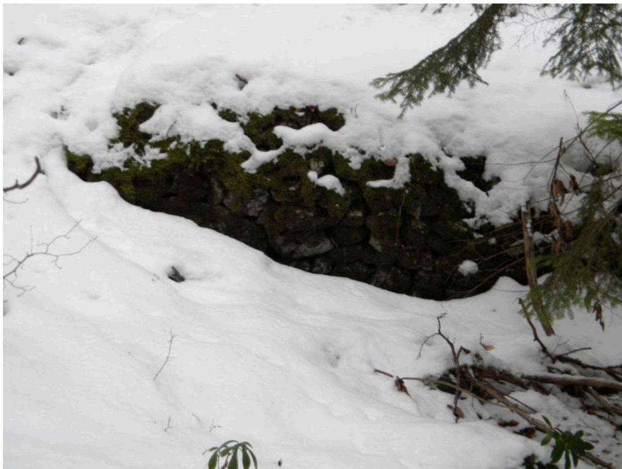
Mur de soutènement dans les anciennes vignes (2008 A10 1783).
