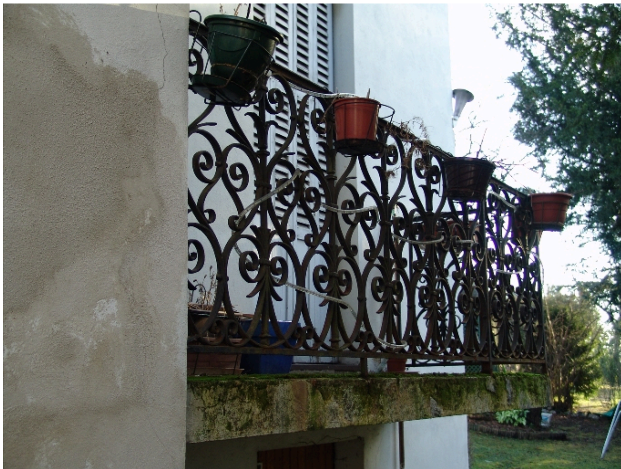
Détail de la ferronnerie du balcon
