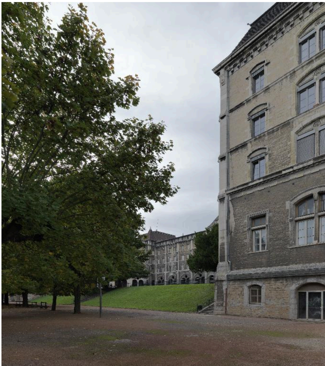
Vue d'ensemble depuis l'est : parc, élévations sur cour, pavillon de l'aile nord-est
