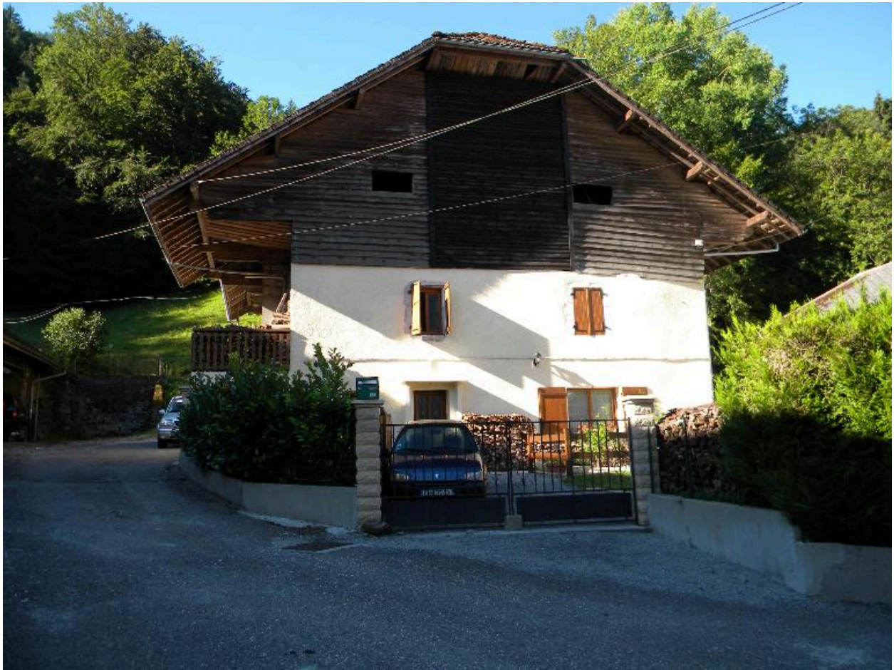
Vue d'une ancienne ferme à la sortie est du village (2008 D4 4022).
