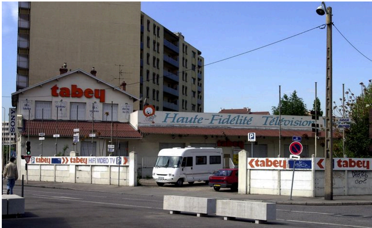
Vue générale depuis l'intersection des rues Domer et Garibaldi
