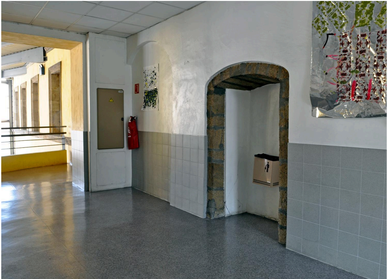
Bâtiment F, 1er étage : baies de l'ancien collège murées (ouvertures entre deux salles du corps de bâtiment est de la cour des pères)
