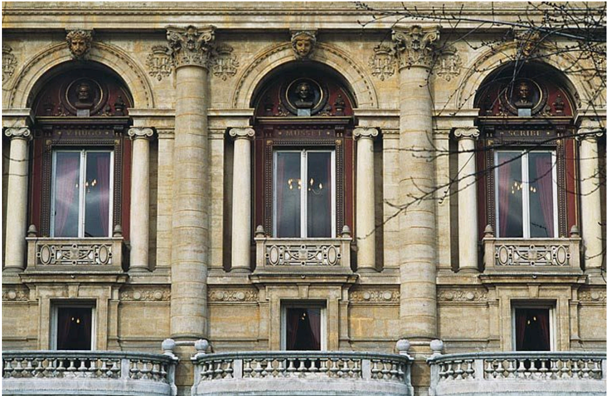
Elévation antérieure : travées centrales des 2e et 3e niveaux, 1992
