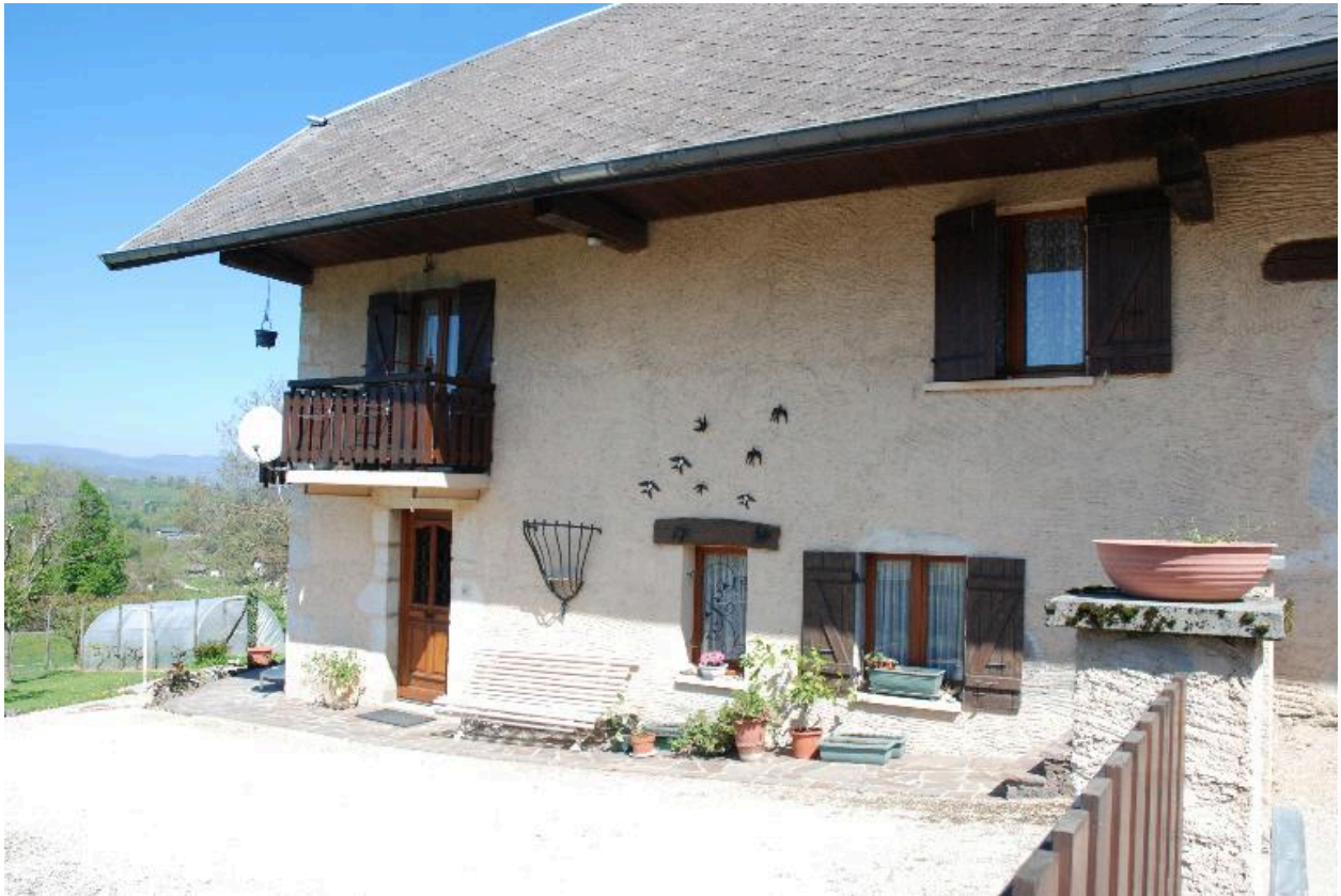
Les Farniers. Ferme, parcelles 2013 E1 90, 91, 92, vue d'ensemble des baies du logis.
