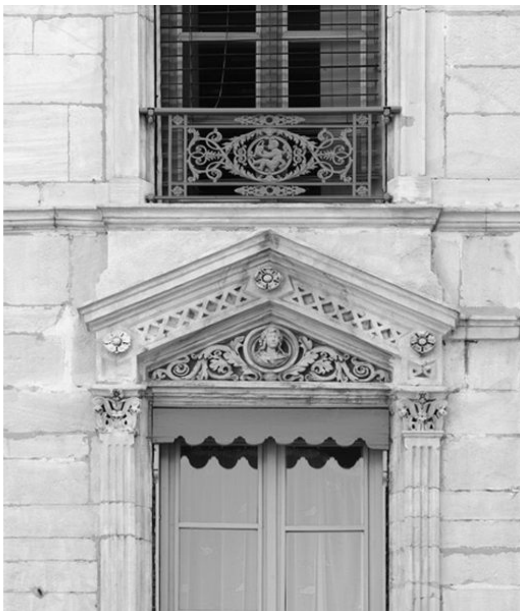
Elévation quai Saint-Antoine, première travée à partir de la gauche : fronton sculpté du premier étage carré et garde-corps du second
