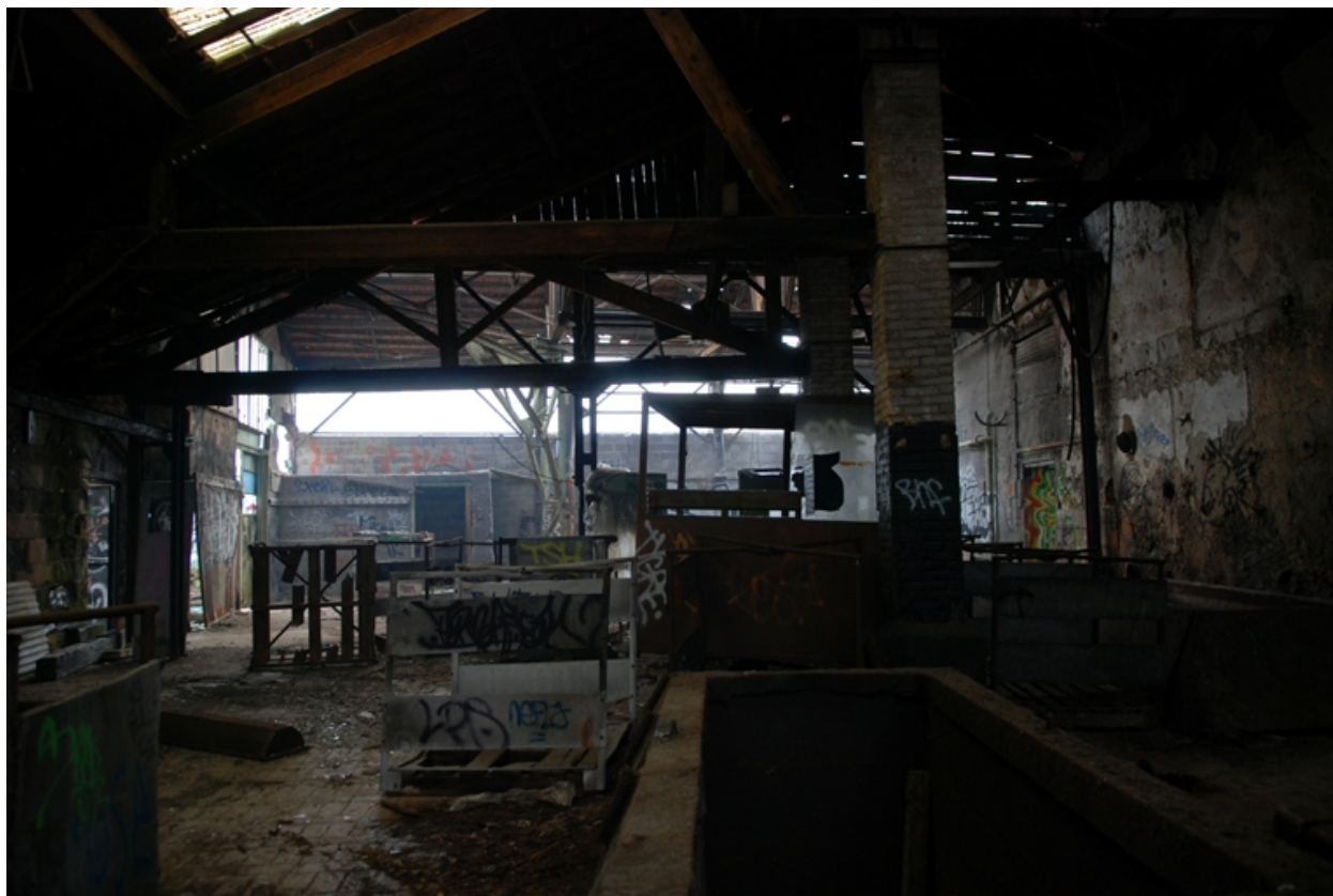
Vue d'ensemble d'un atelier avec cuve rectangulaire
