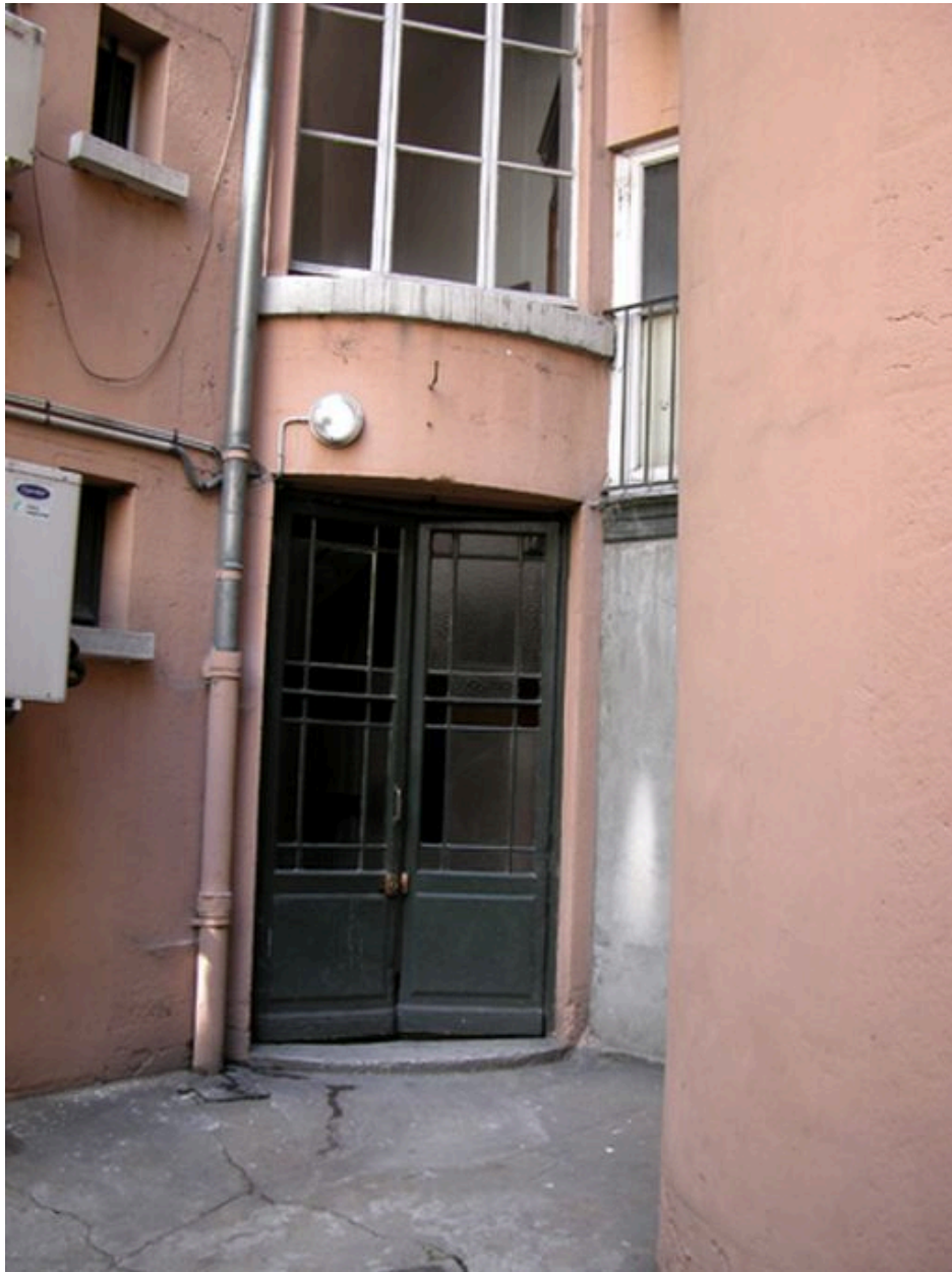
Entrée de l'escalier depuis la cour
