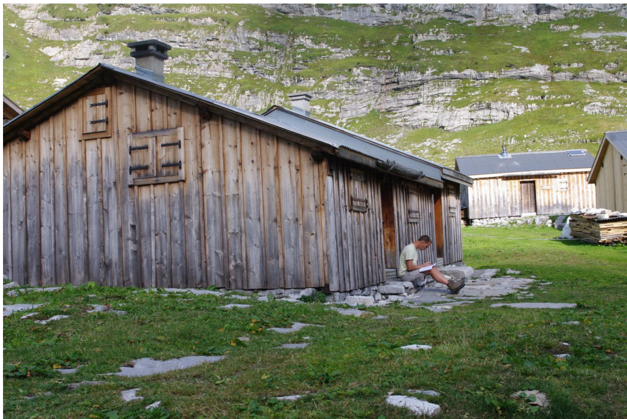
Vue de l'élévation sud-ouest
