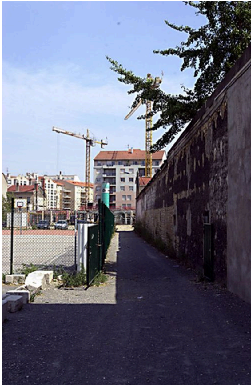
Vue du passage vers le chantier du Bellini depuis le 19 rue du Béguin
