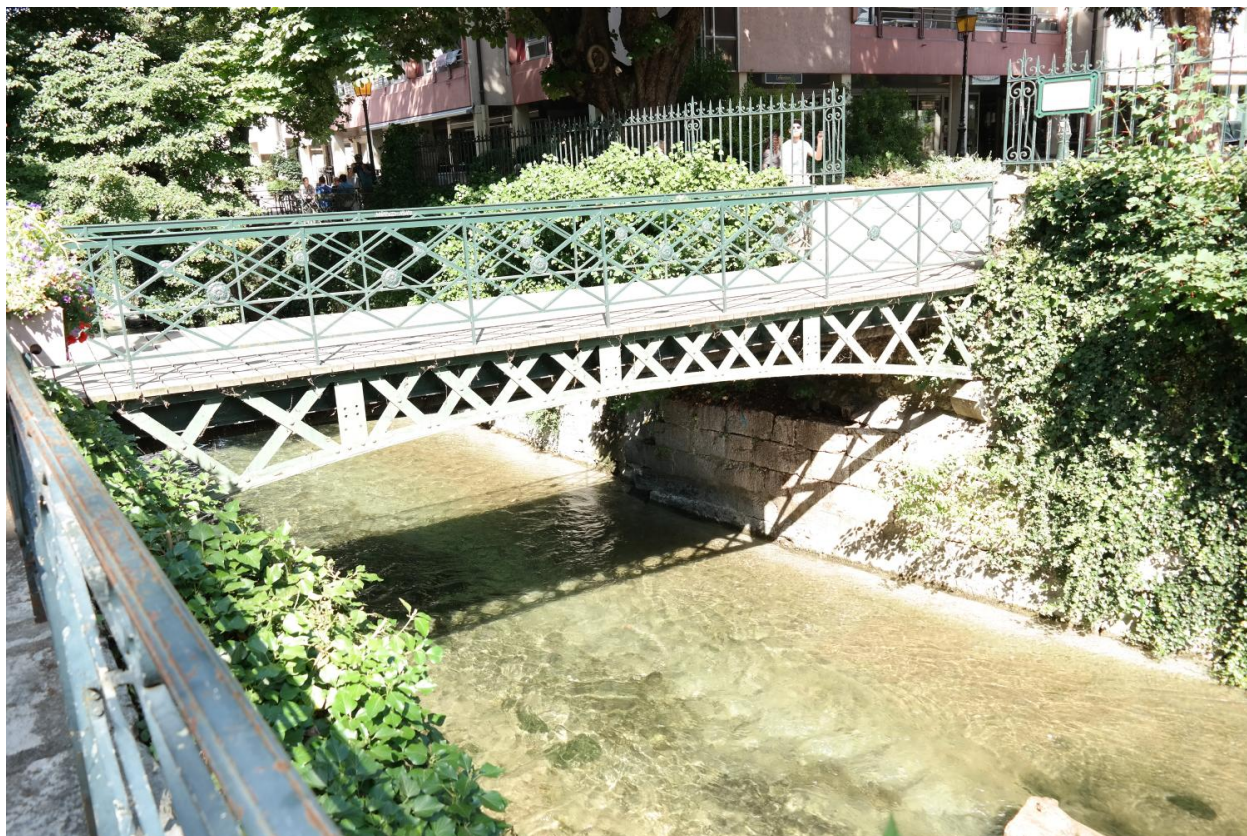
Passerelle de l'Évêché, vue de la face amont
