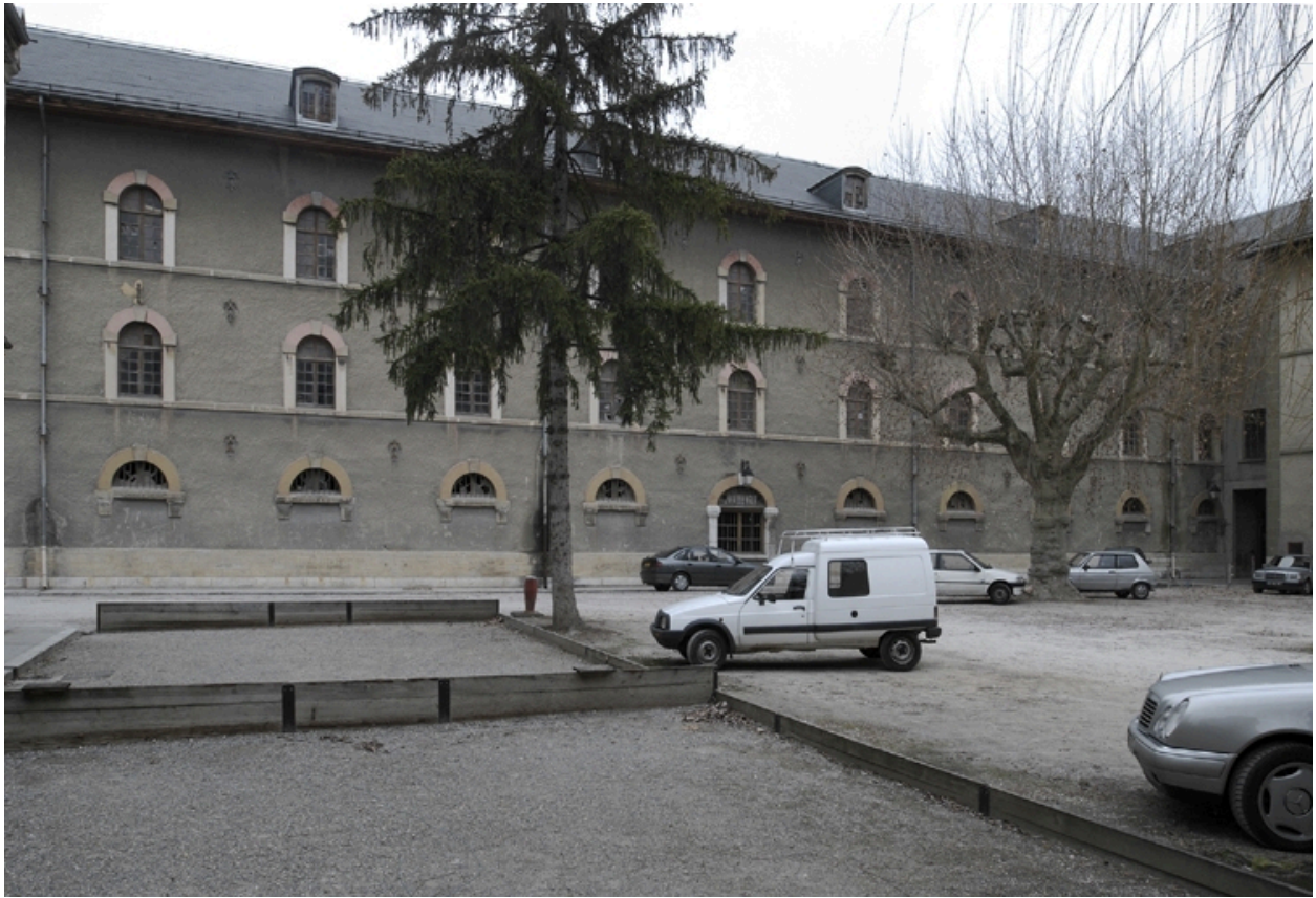
Vue de l'aile nord qui va être conservée
