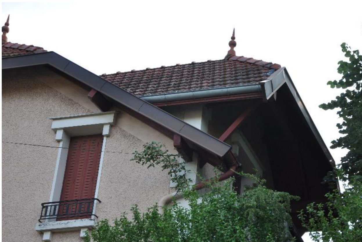
Détail du pignon
