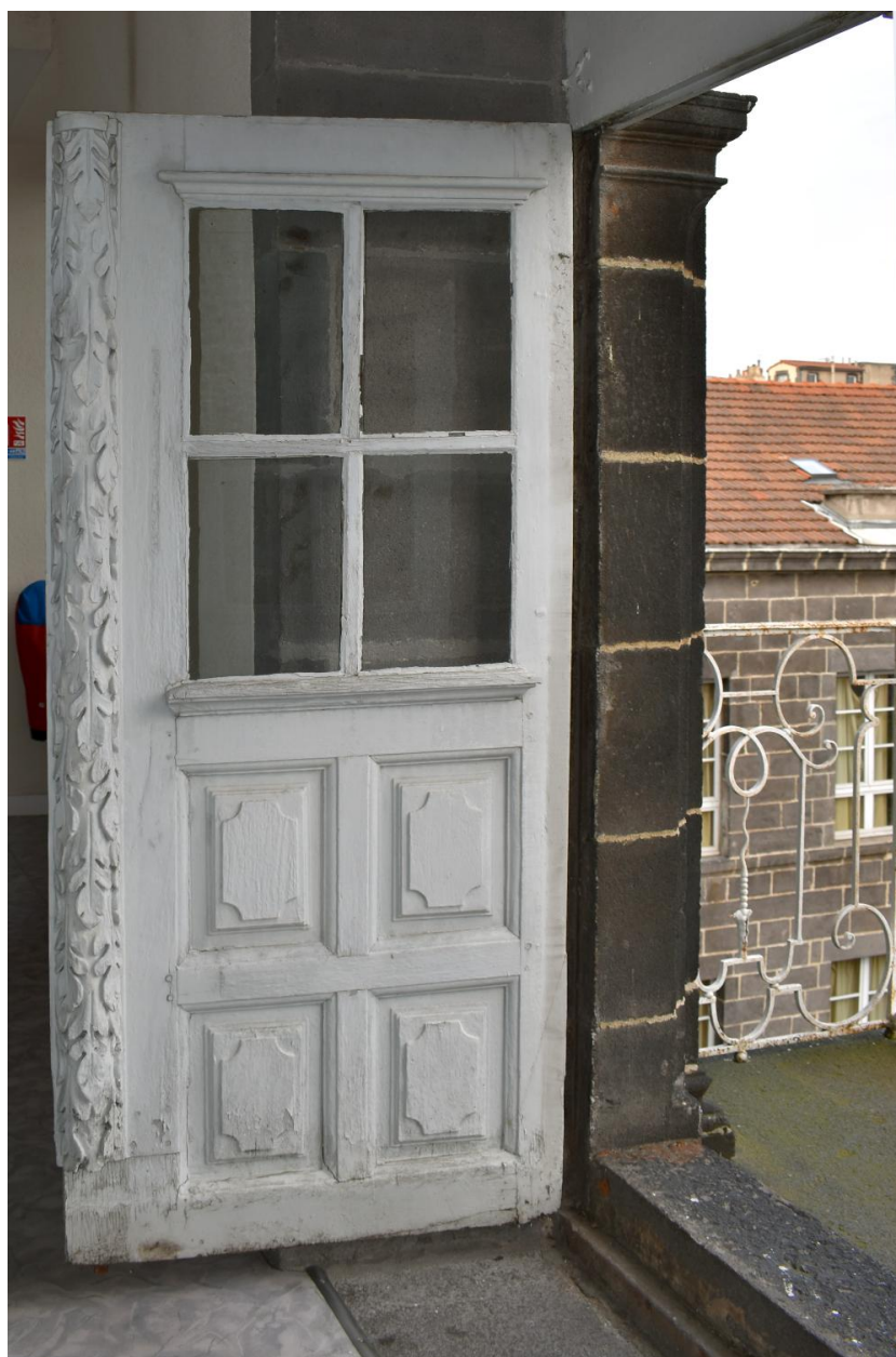
Escalier A, fenêtre du palier du 3e étage : détail d'un vantail côté extérieur
